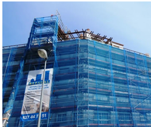
a) Fachada con redes de seguridad y andamios.
